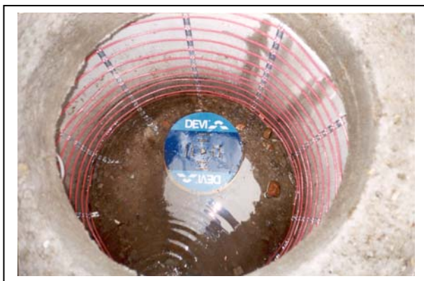
Рис. 4. Монтаж нагревательного кабеля Deviflex™ DTIP-18 в дренажном колодце.
